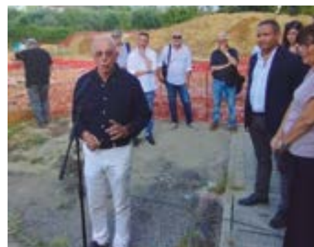
Renzo Macelloni sul cantiere dell'ampliamento
