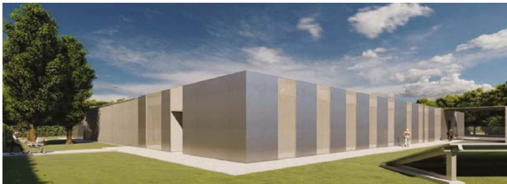
Come sarà a lavori conclusi la “nuova” Casa della Salute
