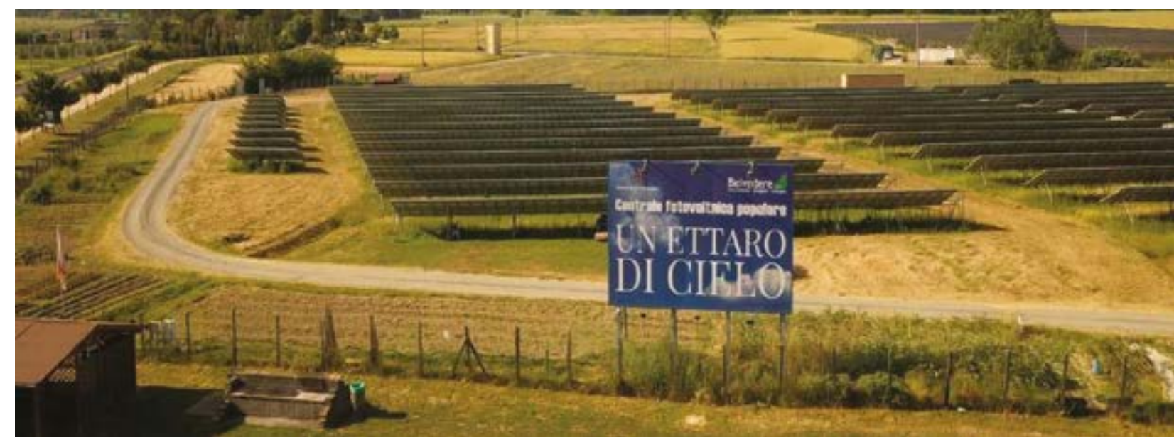
L'impianto fotovoltaico Ettore di Cielo
