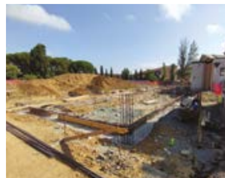
Lo stato di avanzamento del cantiere alla Rosa
