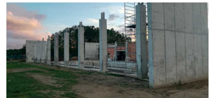
Il cantiere della piscina invernale agli impianti Alfredo Pagni
