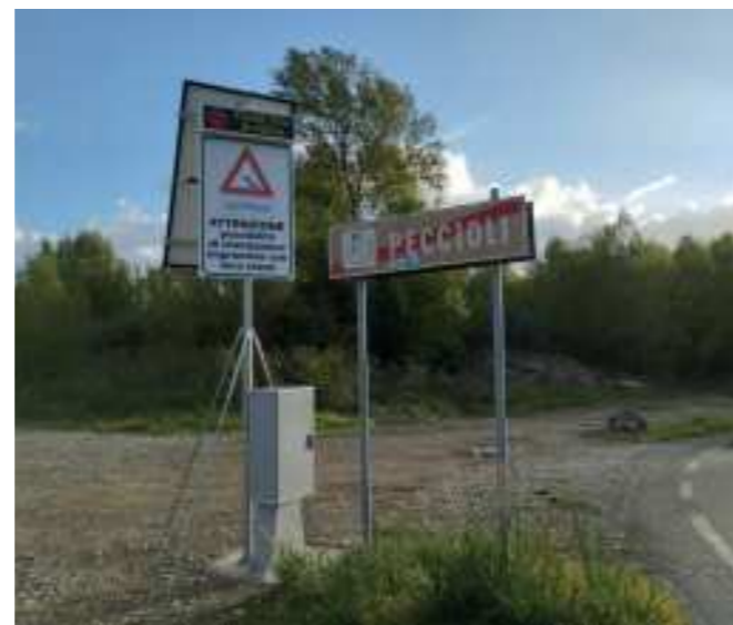
Nelle immagini qui sopra e sotto i semafori di segnalazione della piena sul fiume Era
