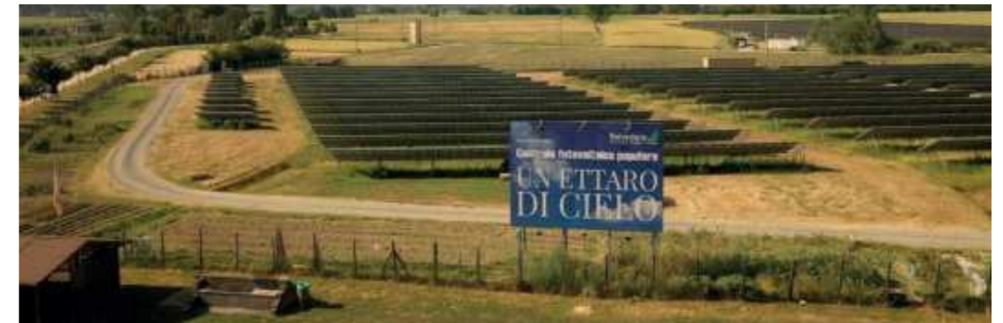
L'impianto fotovoltaico Ettaro di Cielo lungo la strada provinciale della Fila
